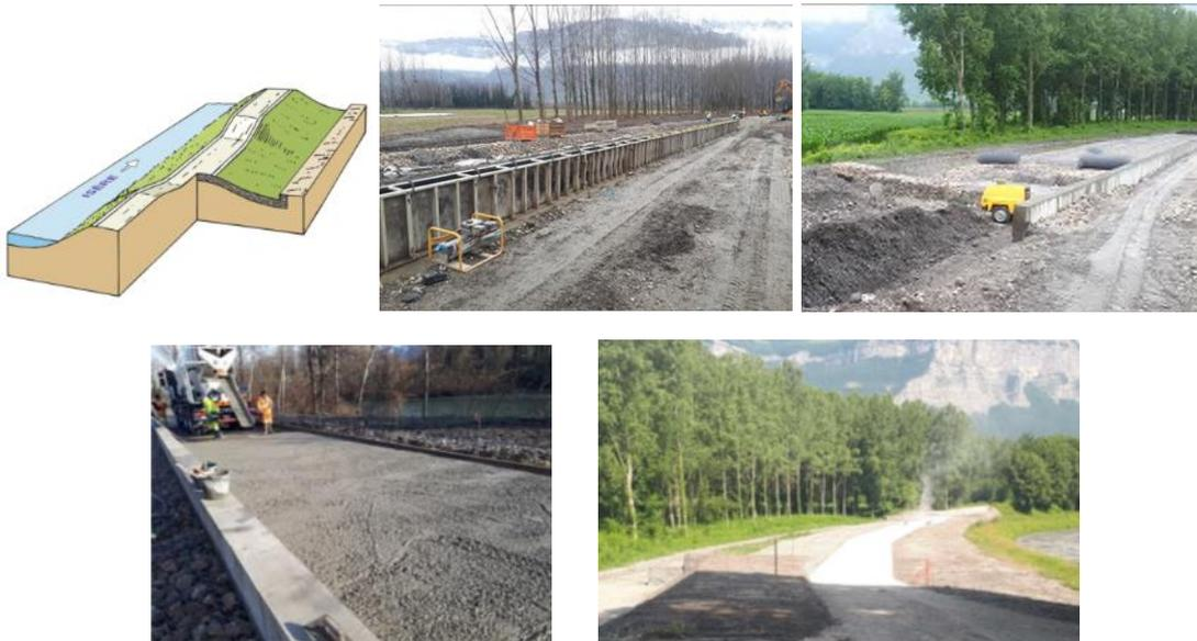
**Des déversoirs de sécurité** : pour une crue très exceptionnelle, au-delà de celle observée en 1859, des déversoirs sont prévus pour éviter un déversement non maîtrisé au-dessus des digues pouvant engendrer leur rupture.
